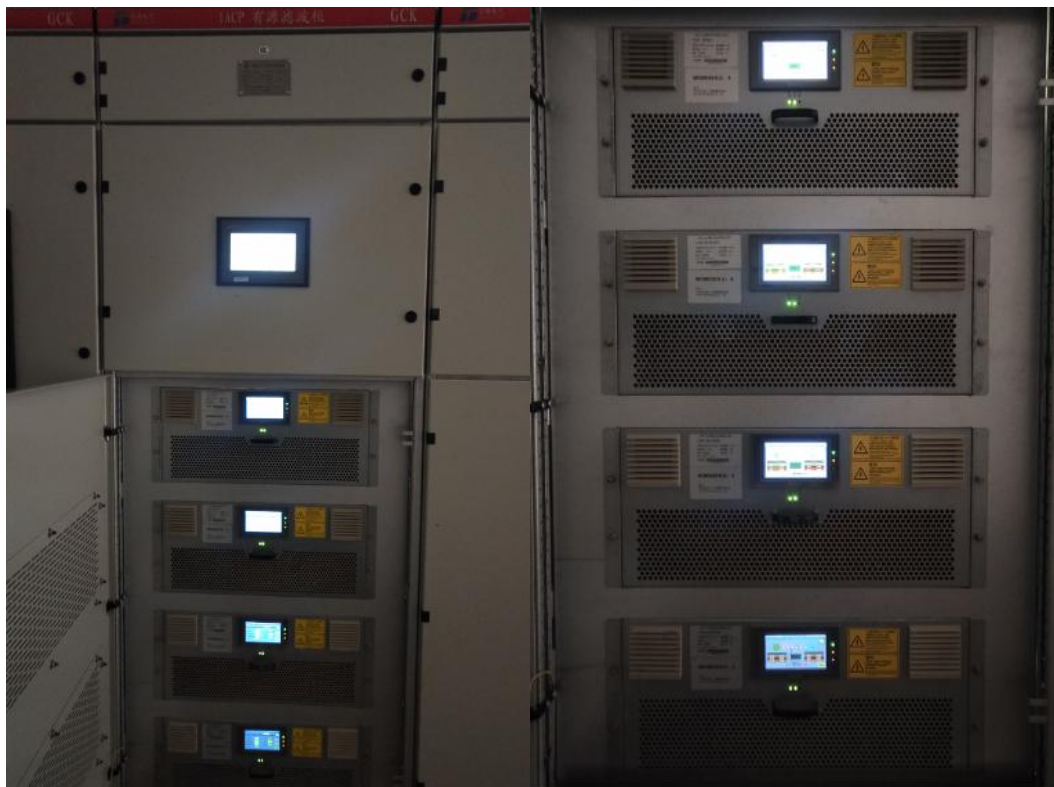
图 5：有源滤波器（容量：APF-450A）在秋滨污水处理厂现场运行图
